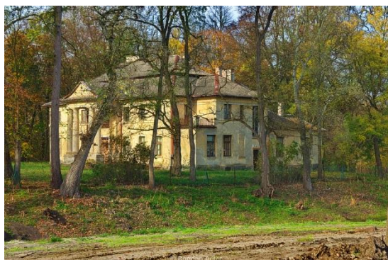
Pałac oraz jego otoczenie w Kamionie
